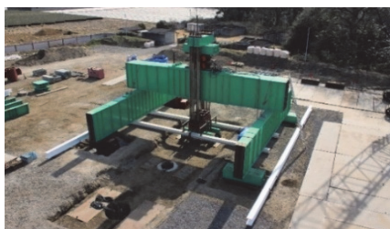
写真-1 載荷装置の全景
