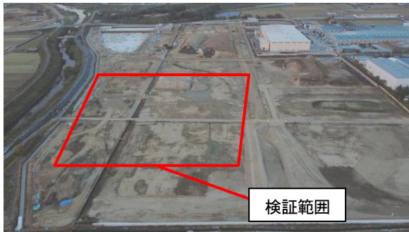
写真-4 施工現場全景
