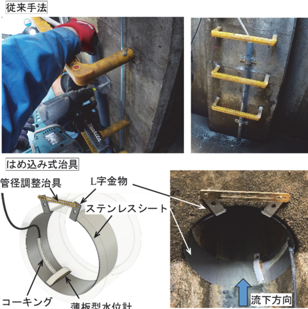
図-9 水位計センサの固定治具
