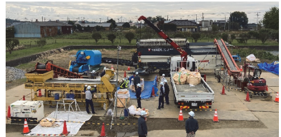
写真-1 試験状況写真
