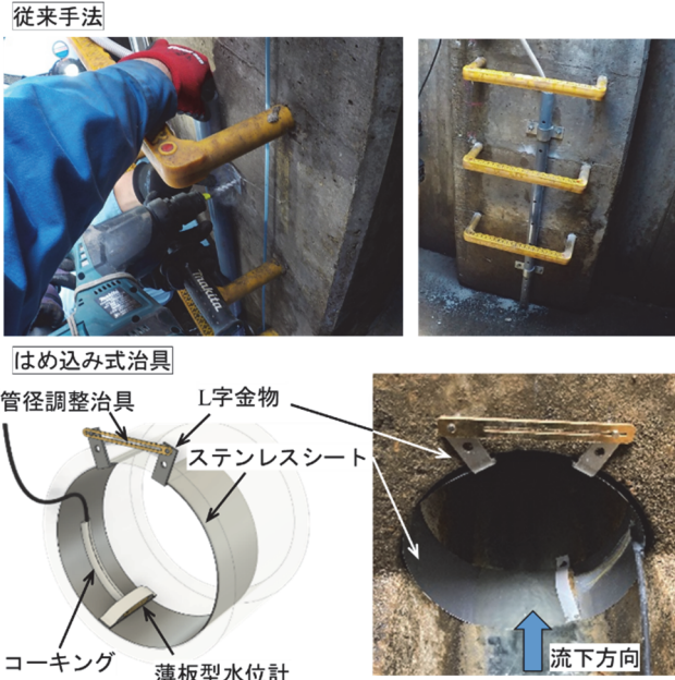
図-9 水位計センサの固定治具
