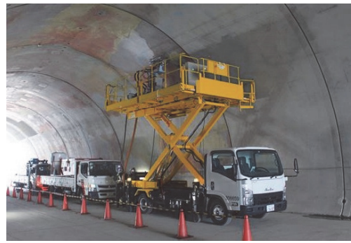
写真一七 性能確認実験の全景
