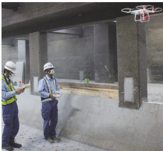
写真-5 UAVによる写真撮影
