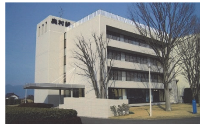
写真-1 竣工後30年が経過した免震建物
