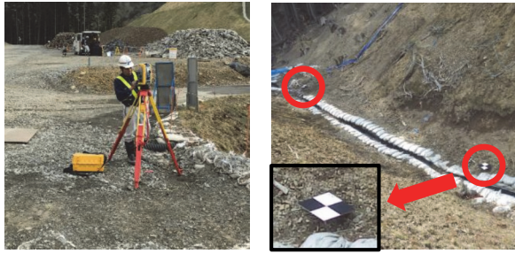
図-3 標定点(補正点) 測量・対標設置
