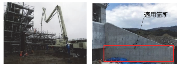
写真-5 山田町大沢水門における現場適用 (左: 打設時、右: 打設後)
