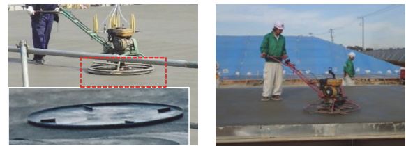
工程：円盤押え（アマ出し） 羽根押え 機械： トロウエル
