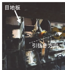
写真-3 目地板引抜き状況
