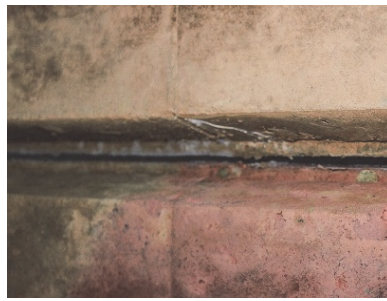
写真-5 目地部の仕上がり(側壁部) 写真-6 目地部の仕上がり(天端部)
