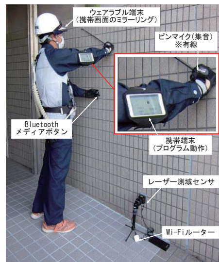
写真-1 「外壁タイル打診調査支援システム」使用状況
