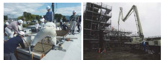
写真-2 現場適用状況 (左: 織笠漁港, 右: 大沢水門)
