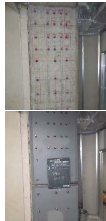
写真-1 一面耐震補強工
