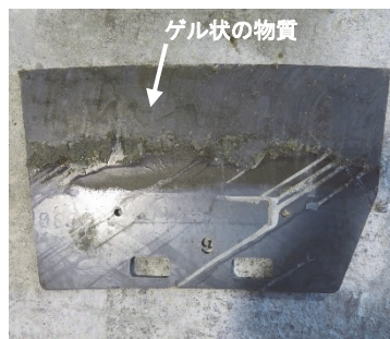
写真-4 引抜き後の目地板の状況
