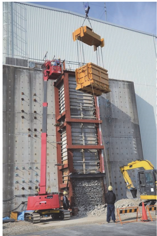
写真-5 シャフトの外観（実験状況）
