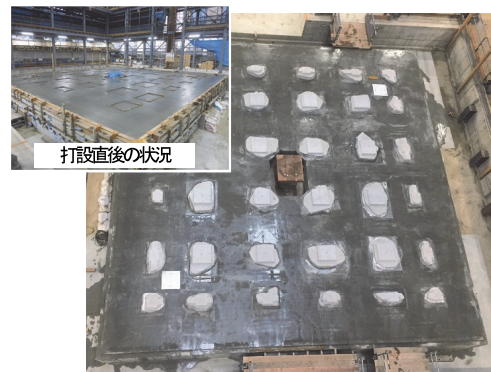
写真-3 スラブの出来形 (礎石設置後)
