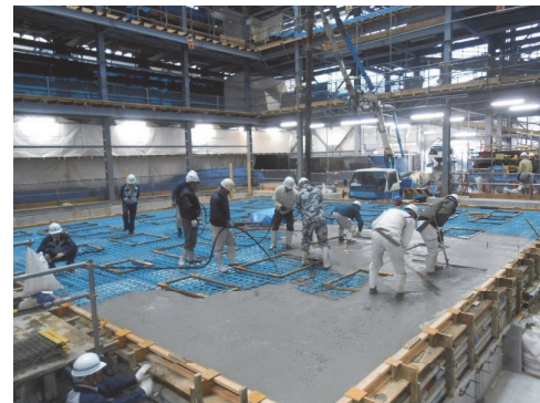
写真-2 打込み状況
