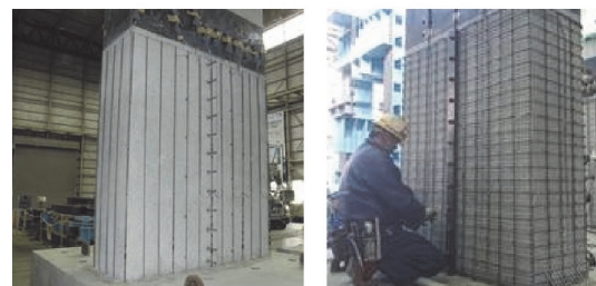
(a) 軸方向鉄筋の設置 (b) せん断補強鉄筋の組立
