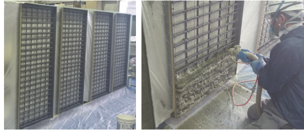
模擬壁面 (L型擁壁) 吹付け状況 写真-6 吹付け試験状況
