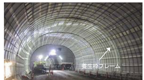
写真-1 覆工コンクリートの養生状況
