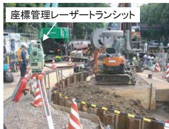
写真-2 打設精度管理
