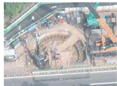
写真-3 実施工状況（上空写真）
