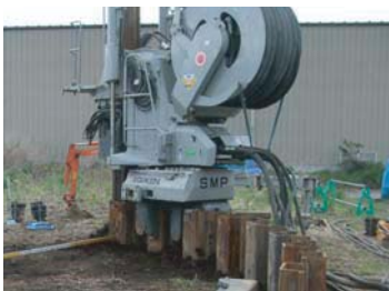
写真-1 鋼矢板の円形打設
