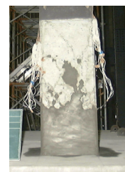
(d) 断面修復完了
