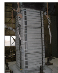
(e) 補強完了
