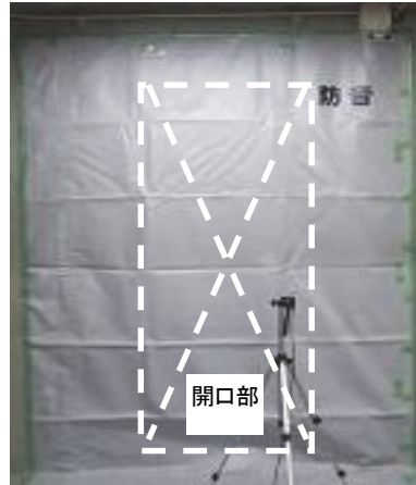
写真-4 防音シート
