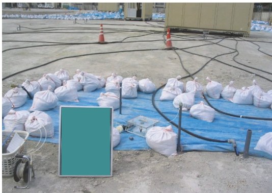
写真－9 想定施工状況（注入工法）
