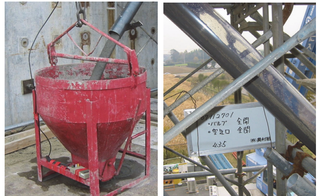
写真-6 モルタル流下状況 写真-7 透明管付着状況
