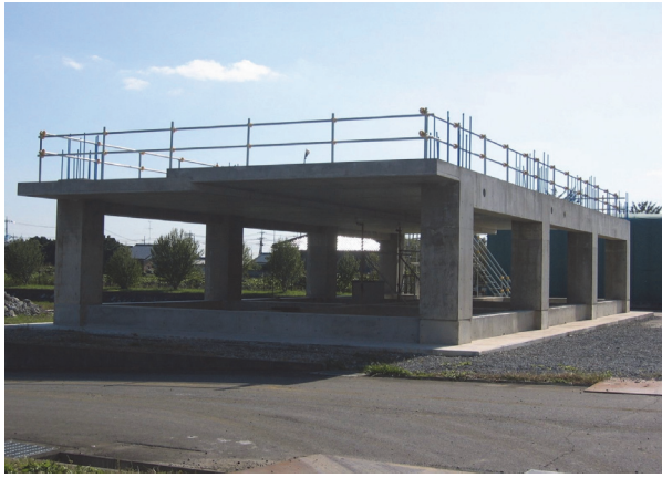
写真-1 試験スラブの全景
