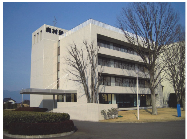
写真-1 建物外観
