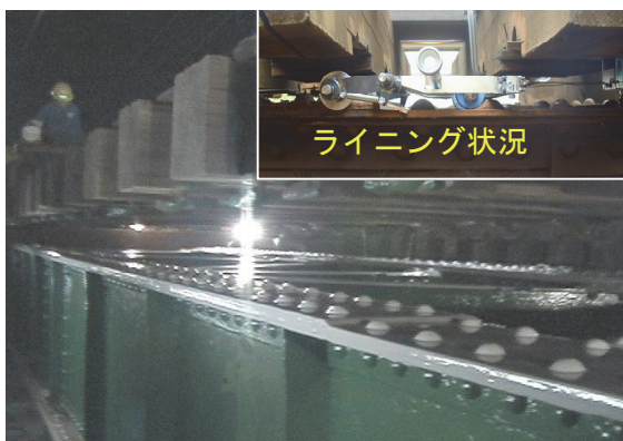
写真-8 桁上ライニング完了状況
