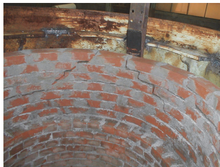
写真-4 楔機構による解体状況
