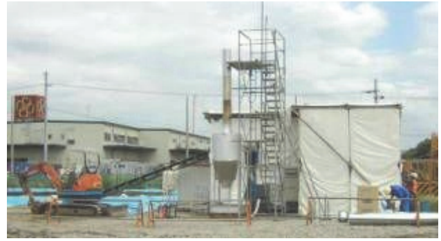
写真-3 KO-C 重油系油汚染土壌の加熱処理状況
