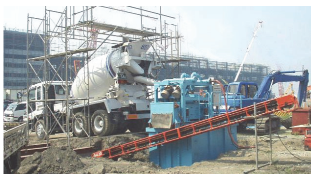
写真-2 ID 潤滑油系油汚染土壌の洗浄処理状況
