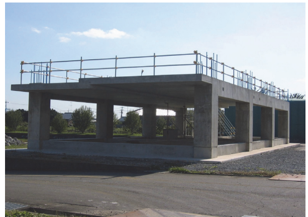
写真-1 実大試験体写真
