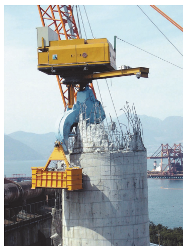
写真-1 NOCC工法施工状況
