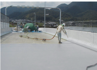
写真-3 ライニング状況
