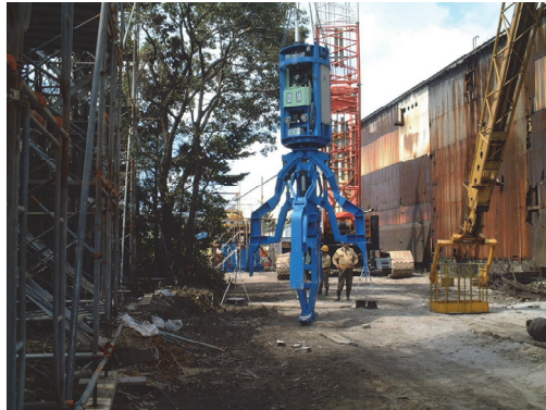
写真-6 実証実験場所の状況
