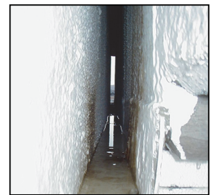
写真-7 防水状況
