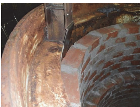
写真-2 楔機構による解体
