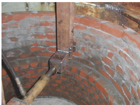
写真-3 圧入機構による解体
