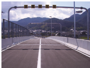
写真-4 舗装完了
