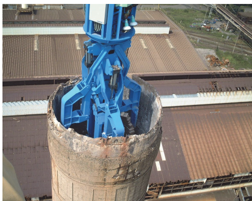
写真-7 煉瓦解体状況
