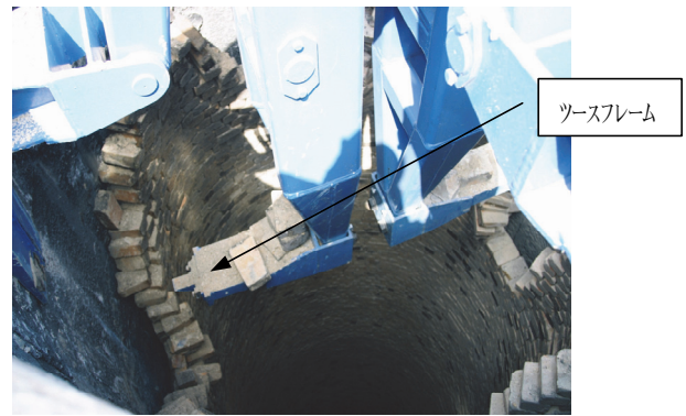
写真-8 煉瓦解体状況
