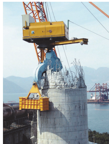
写真-1 NOCC工法施工状況
