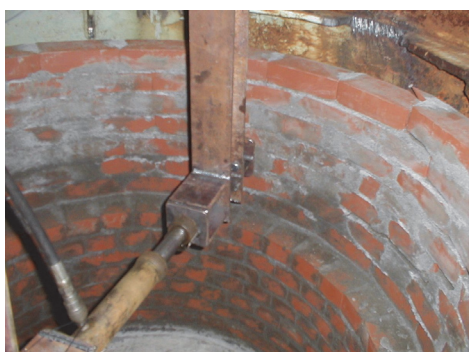
写真-3 圧入機構による解体
