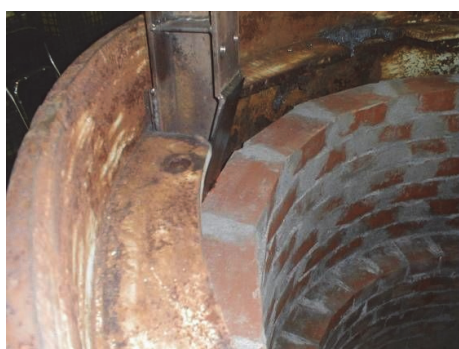
写真-2 楔機構による解体
