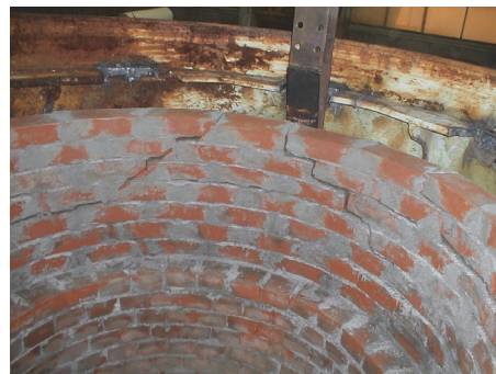
写真-4 楔機構による解体状況
