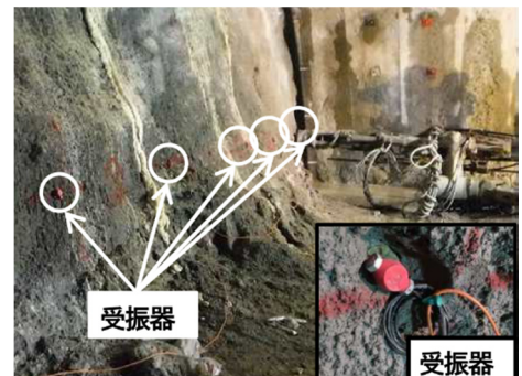
切羽面に設置した受振器
