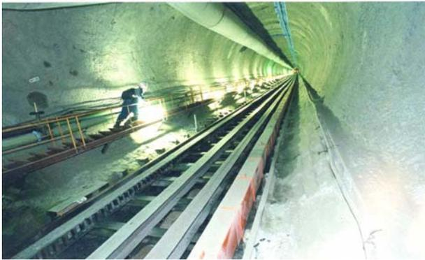
水圧管路斜坑(勾配 48 度) 坑内状況
