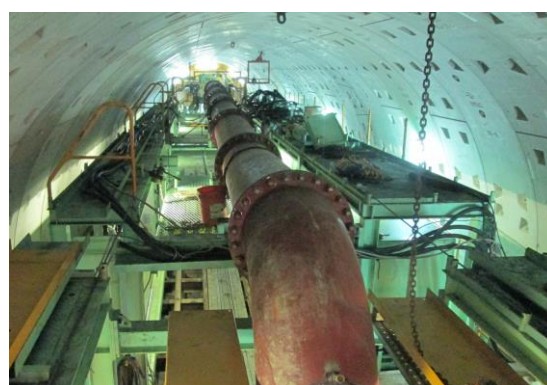
写真-2 噴発防止用鋼管（φ600 mm、L=30m）
