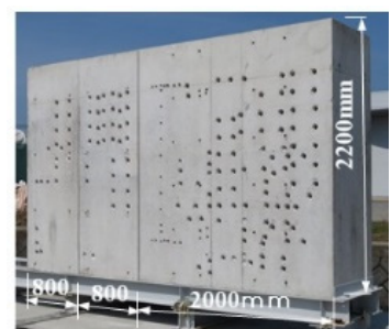
写真-5 実験後のRC壁試験体
