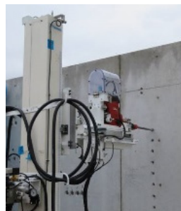
写真-4 小径用自動削孔装置・削孔状況
