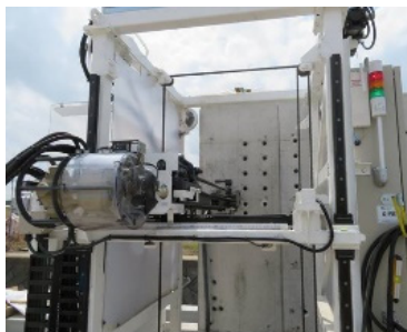
写真-3 大径用自動削孔装置・削孔状況
