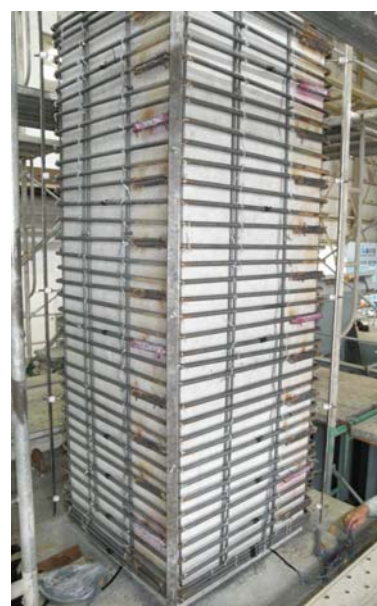
補強鉄筋巻立て完成状況
