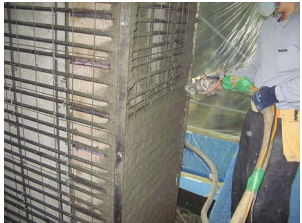
吹付けコンクリート施工
