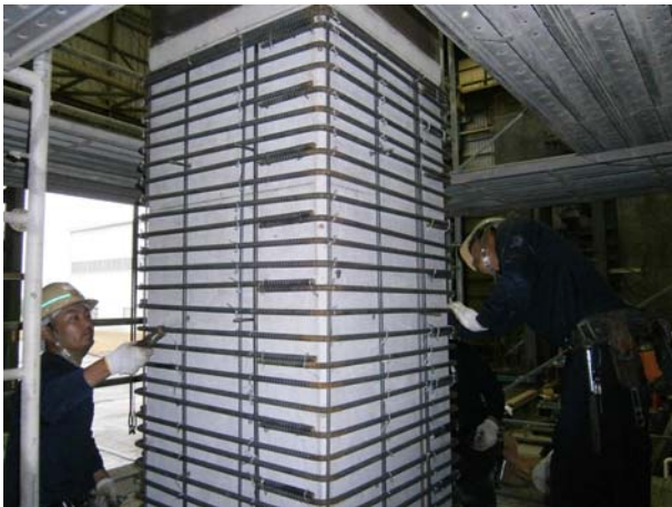
せん断補強鉄筋巻立て
