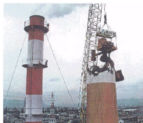
阪神大震災の復旧・復興工事 (豊中伊丹クリーンランド煙突解体 1995年)
