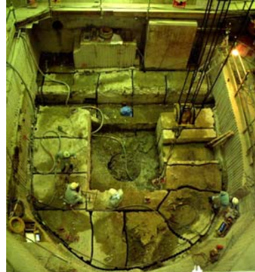
ブロック分割したコンクリートをクレーンで搬出
