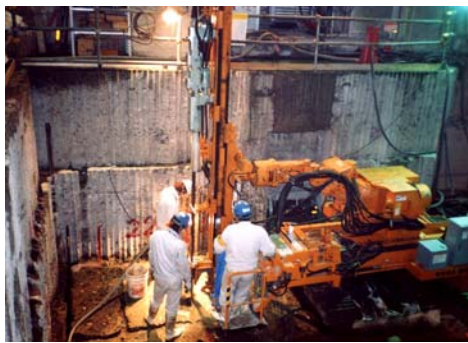
スロットスターによるスロット削孔状況
