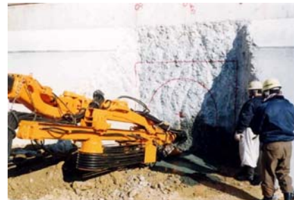
兵庫県「青野ダム堤体穴あけ工事」 SD施工工期:1999.12
