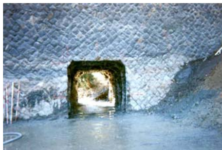
鳥取県「美敷ダム穴あけ工事」 SD施工工期:1995.11~1995.12
