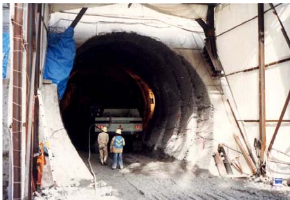
堤体内導水路の施工状況
