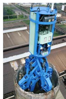
レンガ解体機
