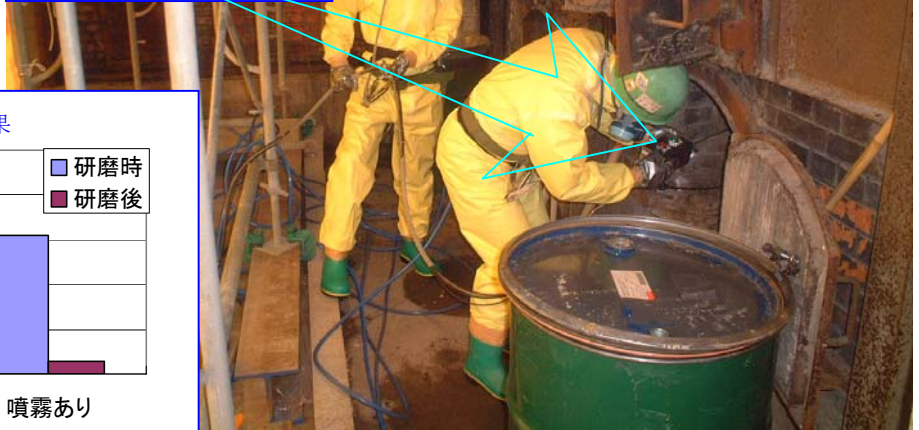
灰出し作業時でのミスト散布状況
