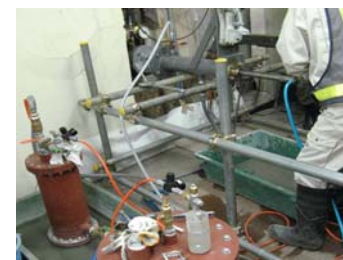
背面水圧コア削孔状況
