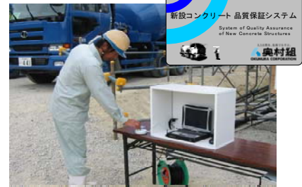
ICカードによるコンクリートの受入
