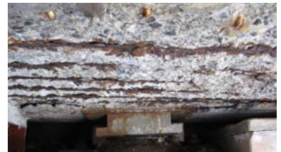
塩害による鉄筋腐食
