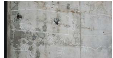
初期欠陥によるジャンカ
