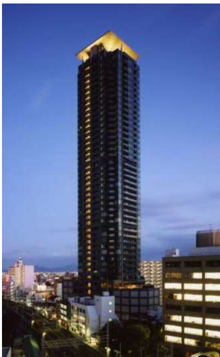
高強度コンクリートを用いた建物例 シティタワーグラン天王寺（43階建）
