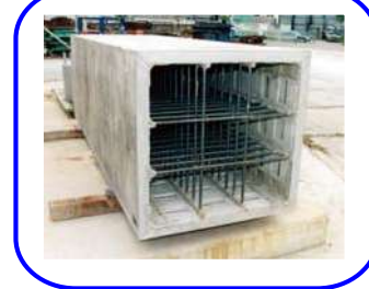
エコカラムと柱・梁主筋の組立て状況
