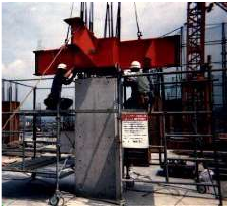
柱梁接合部鉄骨の取り付け状況
