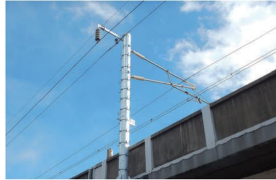
(写真-4) 電車線柱の耐震補強
