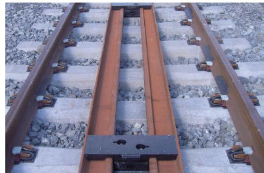
(写真-5) 逸脱防止ガードの敷設状況
