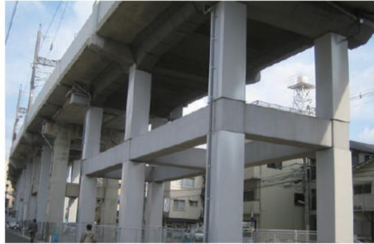
(写真-3) 高架橋柱の耐震補強
