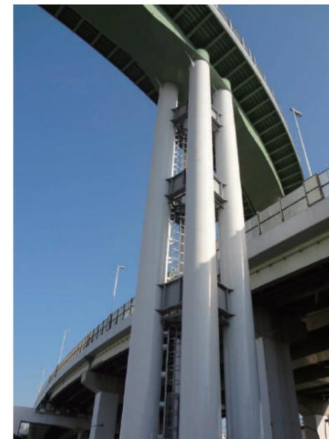
(写真-2) 鋼管集成橋脚
