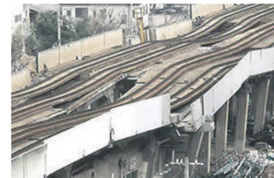
(写真-1) 六甲道高架橋区間の被災状況
