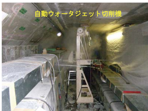
写真2 ボックスカルバート（共同溝）側壁部の耐震補強工事における機械化施工 — 狭隘な空間における作業の効率化 —
