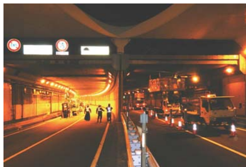
写真3 羽田トンネル天井板撤去工事
