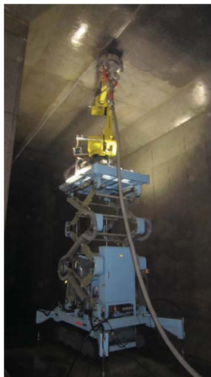
写真1 コンクリート表面処理機の開発 — 作業の効率化、処理品質・安全性の向上 —
