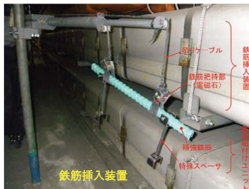
写真2 ボックスカルバート（共同溝）側壁部の耐震補強工事における機械化施工 — 狭隘な空間における作業の効率化 —
