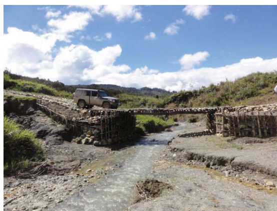
写真2 写真1の渡河部に架設された橋
