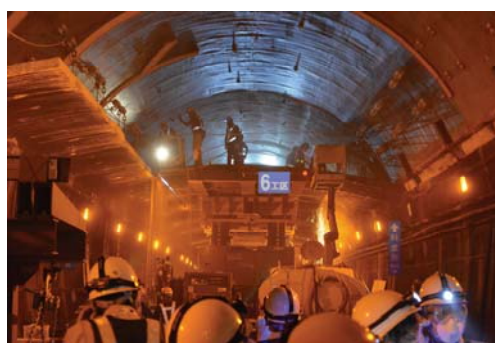
写真4 新神戸トンネル天井板撤去工事
