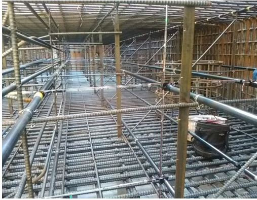
写真－4 クーリングパイプ設置状況（躯体内）
