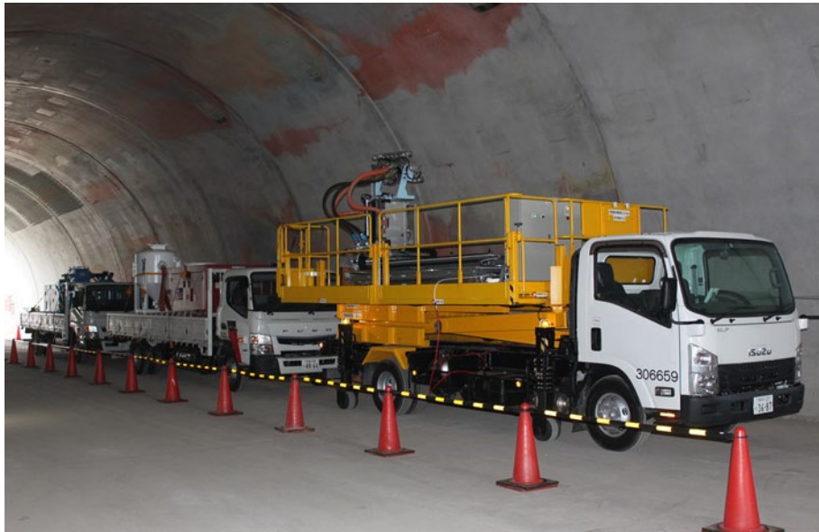
写真－3 曲面天井用研掃システムの車両配置状況
