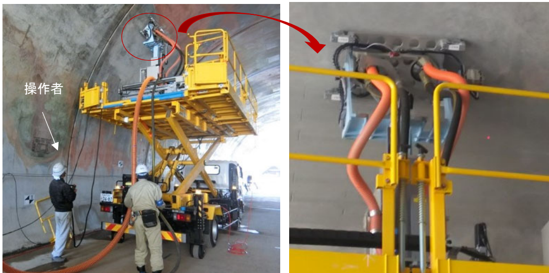
写真－4 性能確認実験の状況
