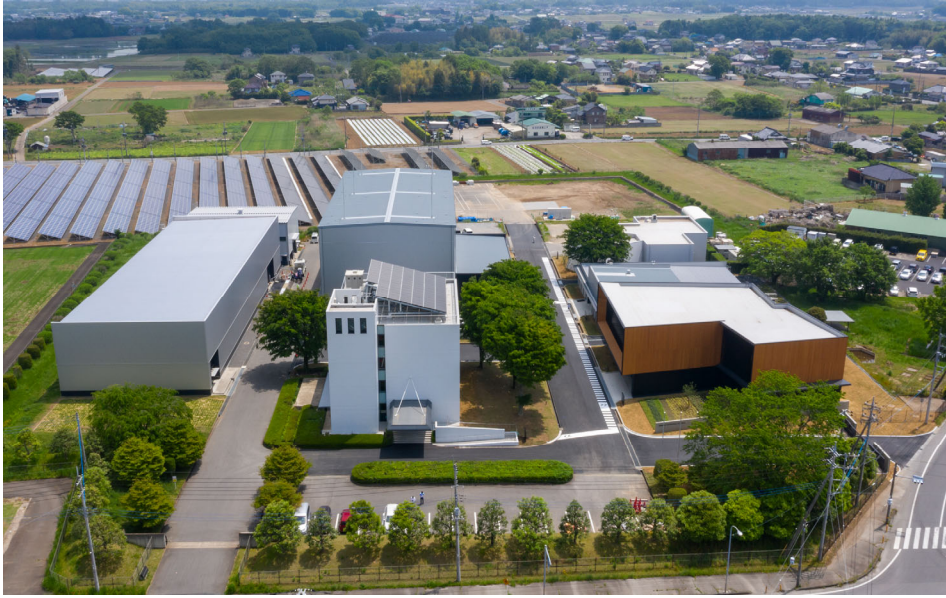
中央手前:管理棟(ZEB 化改修)
