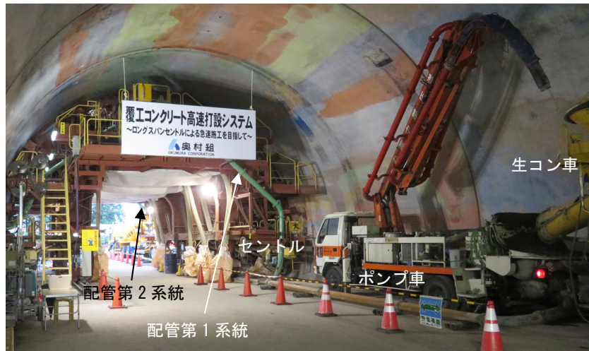
写真-1 模擬トンネルでの覆エコンクリート打設状況（前方を臨む）
