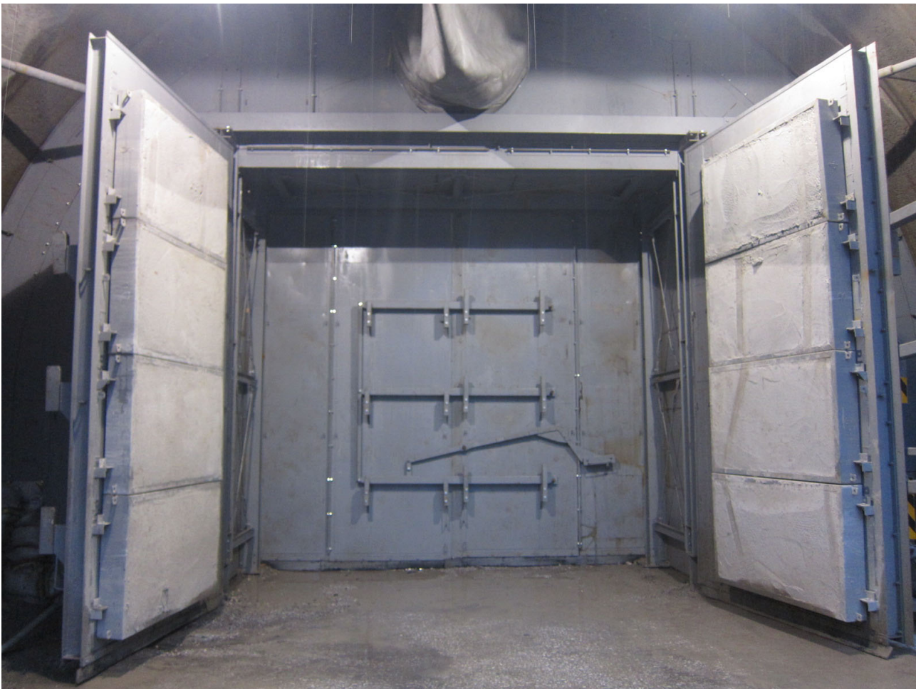
写真 改造型防音扉の設置状況
