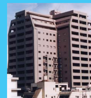
【ハイブリッド免震システムの設計・施工実績】 「プライムタワー・ルミナス立川」 高さ51m 17階 （東京都立川市）
