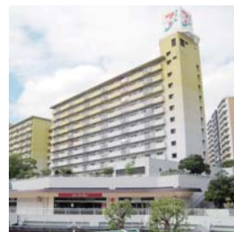
若葉台第1共同住宅3-7棟 (神奈川県横浜市)
