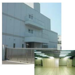
松山第4電気ビル (愛媛県松山市)
