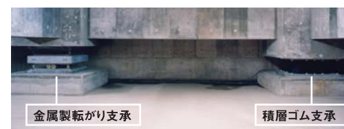
プライムタワー・ルミナス立川の免震装置
