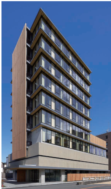
西川口寮外観
