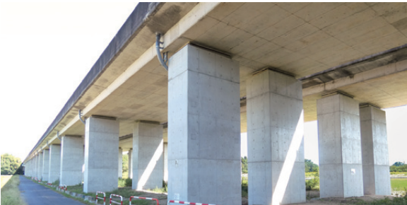
伊勢自動車道 堀之内第二高架橋他4橋耐震補強工事 (三重県津市安東町～松阪市岩内町)
