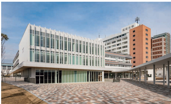
摂南大学寝屋川キャンパス3号館 (大阪府寝屋川市)
