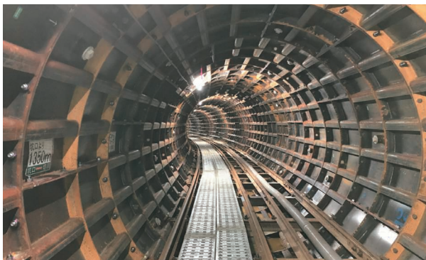
富津千葉高圧幹線建設工事 (千葉県木更津市)
