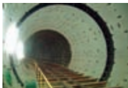
寝屋川流域下水道飛行場南増補幹線(第3工区) 下水管渠築造工事
