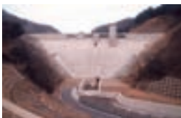
岩井川治水ダム建設工事
