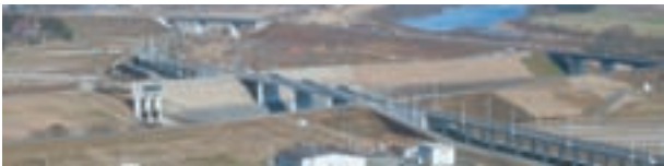
▲ 東北本線平泉・前沢間衣川橋りょう北部高架橋新設他 (岩手県平泉町)
