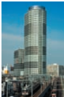
イーストコア曳舟二番館(S棟)▶ (東京都墨田区)
