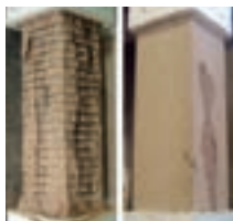
(左:対策なし、右:対策あり) 高強度コンクリート爆裂対策の有無の違い
