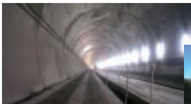
▲東北新幹線 八甲田トンネル工事 (青森県青森市)
