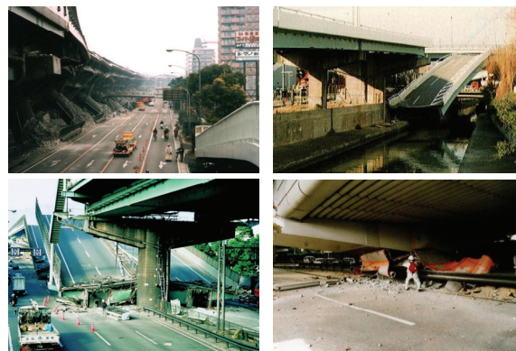
写真-1 兵庫県南部地震の被害状況
