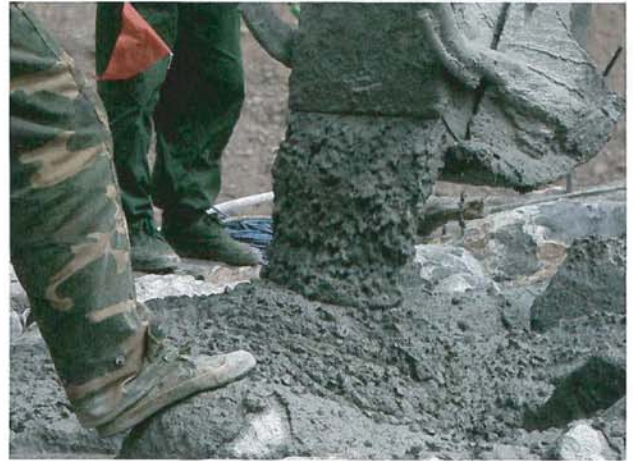
▲ SCC の充填状況
