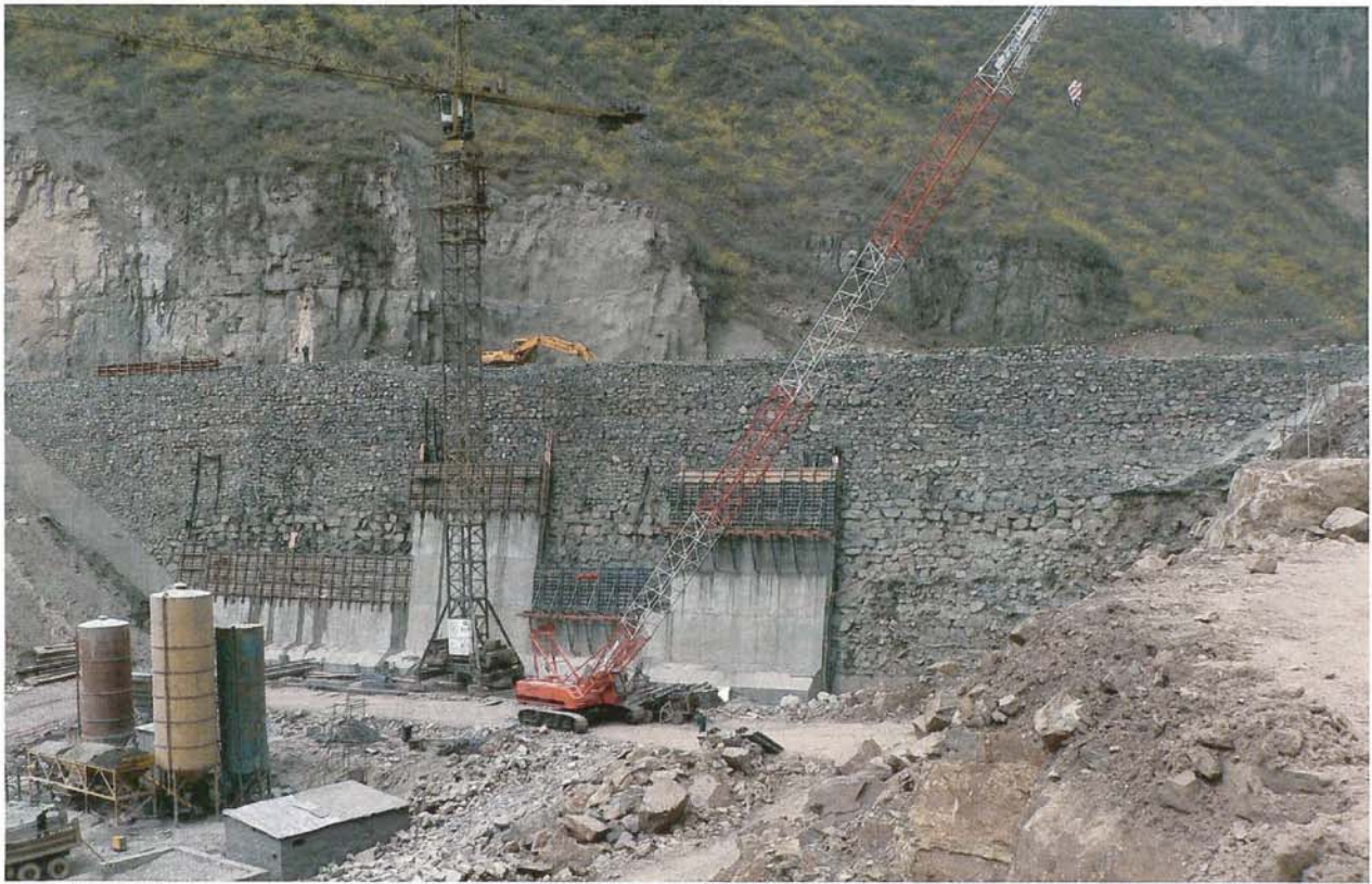
▲ 施工中の脇ダム全景
