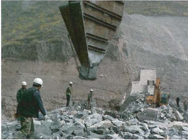
▲ バケットで SCC を運搬
