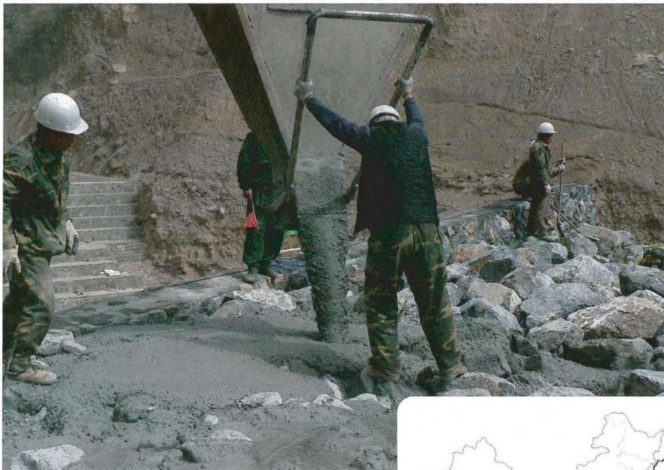
▲ 敷均した大粒径粗骨材中に充填中の SCC
