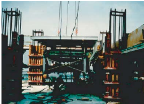
写真1 1980年頃のシステム型枠
