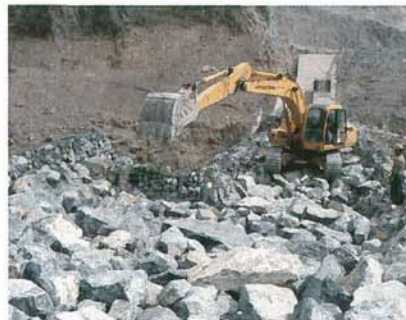
▲ 大粒径粗骨材の敷均し
