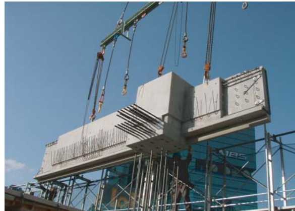
写真2 最近の柱・梁を一体化したPCa部材
